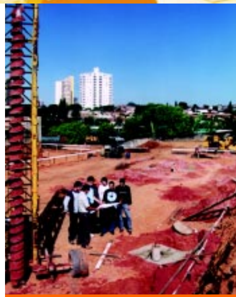
Alunos em trabalho prático em canteiro de obras
