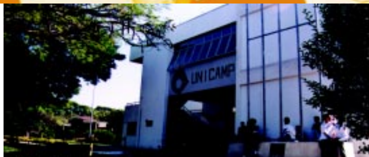
Aspecto da fachada do Ceset, em Limeira
